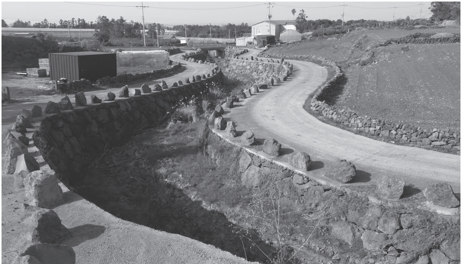
▲ 제주도내 한 소하천. 제주의 수많은 하천이 옛 모습을 잃고 콘크리트로 정비되어 우수 배수로의 역할 밖에 하고 있지 않다.
