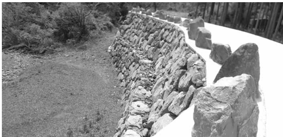
▲ 천미천의 중류에 해당하는 천미천 구좌지구 공사. 높은 제방이 만들어졌다.
